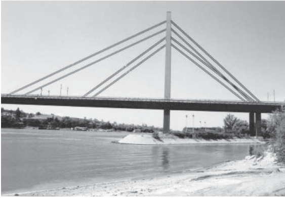
Nowy most kolejowy przez Sawę w Belgradzie
